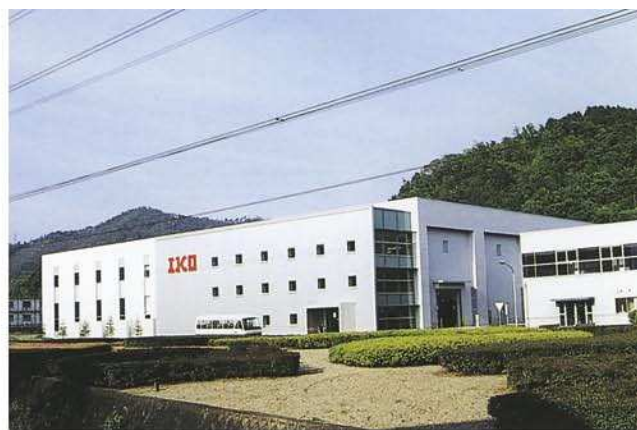
Производственная площадка в Гифу № 2
