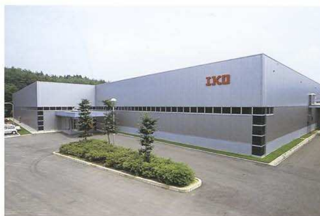
Производственная площадка в Гифу № 3
