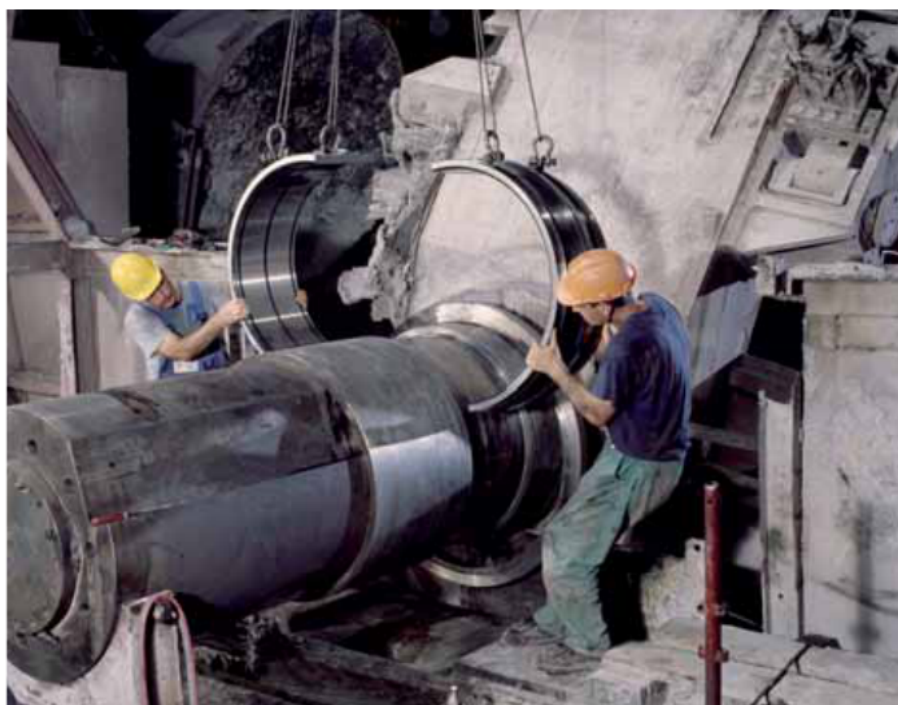
Монтаж крупногабаритного разъемного сферического роликоподшипника
