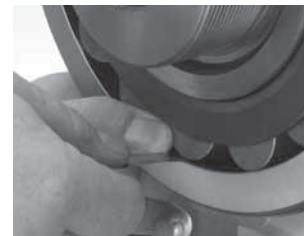
Рис. 15. В процессе монтажа производится измерение РВЗ ненагруженного ролика.
