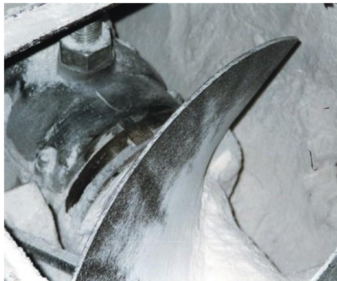
Подвесной узел с манжетными уплотнениями для эксплуатации в тяжелых условиях, установленный на цементном заводе
